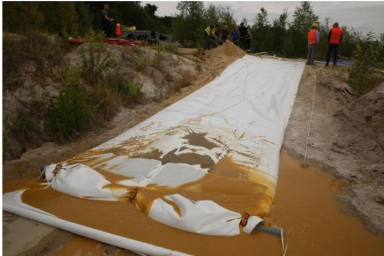
**Abbildung 5:** Befüllung des wasserseitigen Moduls
