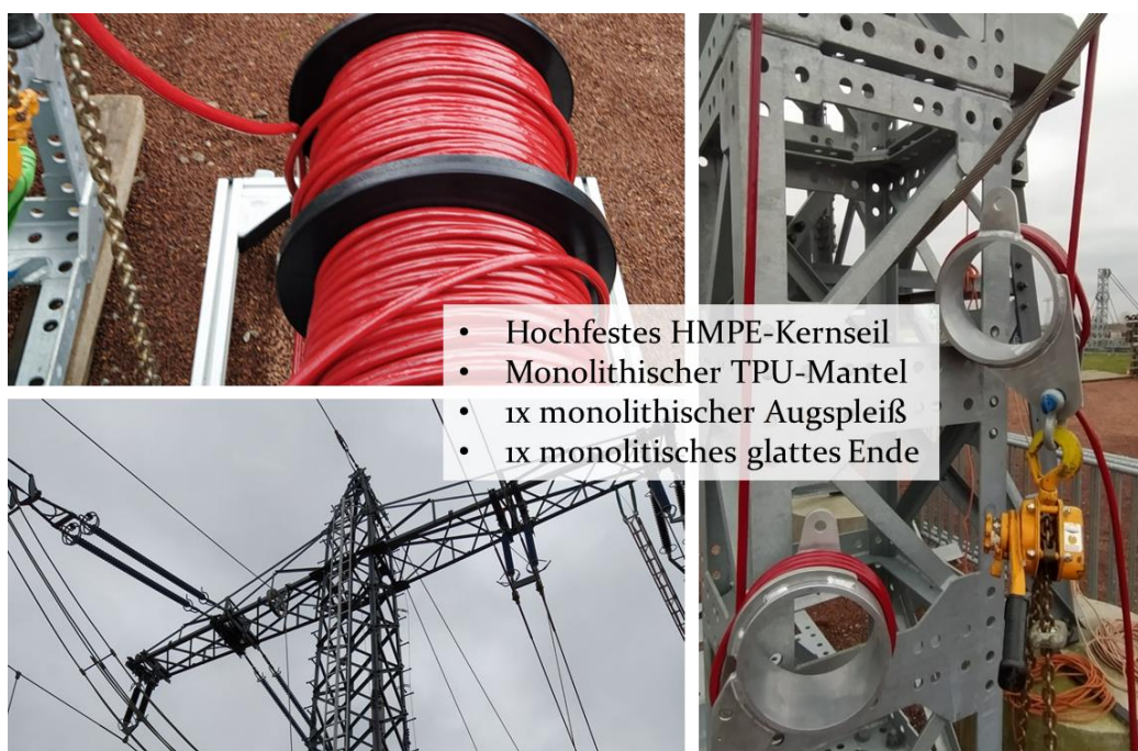
Abbildung 5: Kunststoffummantelte Einzugsseile im Freileitungsbau
